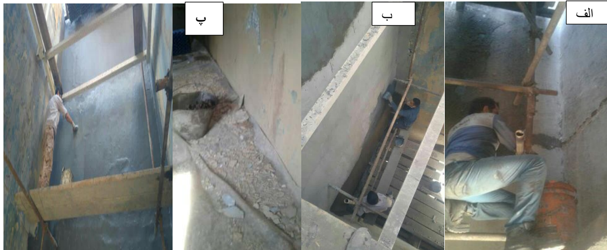
الف) ترمیم ترک ها با ملات پایه سیمانی ب) اجرای پوشش آب بند با مواد مخصوص پ) اجرای سند پلاست دیوار ها
