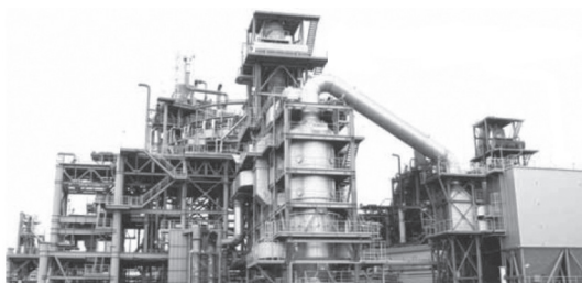
فرآیند RHF Fastmet مورد استفاده برای بازیابی آهن از ضایعات کارخانه برای بازیافت در کوره بلند
