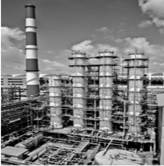
شکل ۶. تجهیزات جذب کننده تصفیه گاز باطری های کک سازی اندونزی
