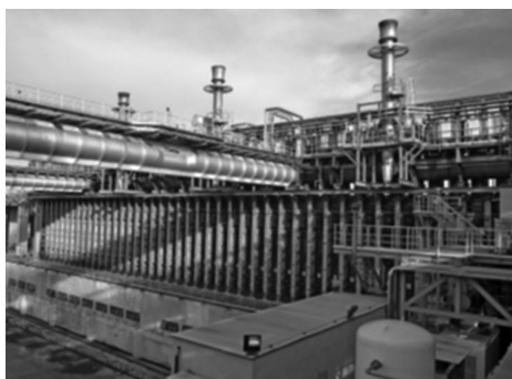
شکل ۲. نمایی از سمت کک باطری های کک سازی اندونزی
