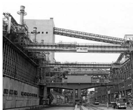
شکل ۳. نمایی از سمت ماشین باطری کک سازی شماره ۱ اندونزی
