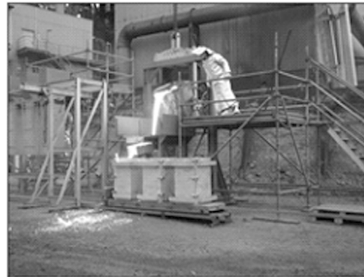
شکل ۳. اولین آزمایشات گرانوله کردن خشک سرباره در سال ۲۰۱۱
