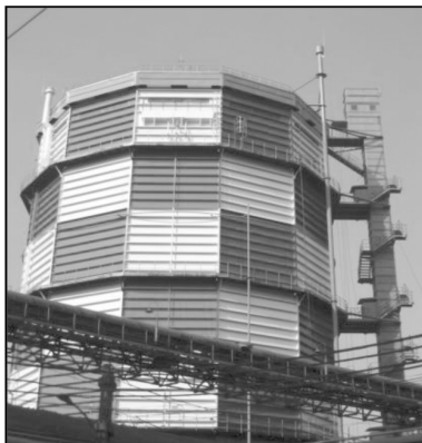
شکل ۲. مرحله پایان ساخت و نصب گاز هلدر.
