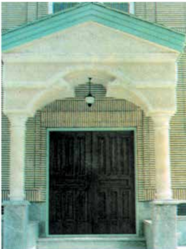
شکل ۲۰-۵- ستون‌سازی - سرستون‌سازی - قوس‌سازی سه کمانه - ابزارزنی - سیمان‌بری
