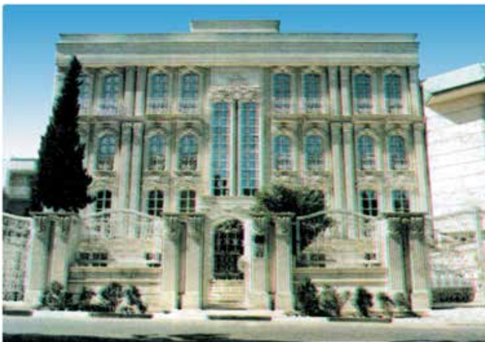
شکل ۲۱-۵- اجرای سیمان‌بری باروک
