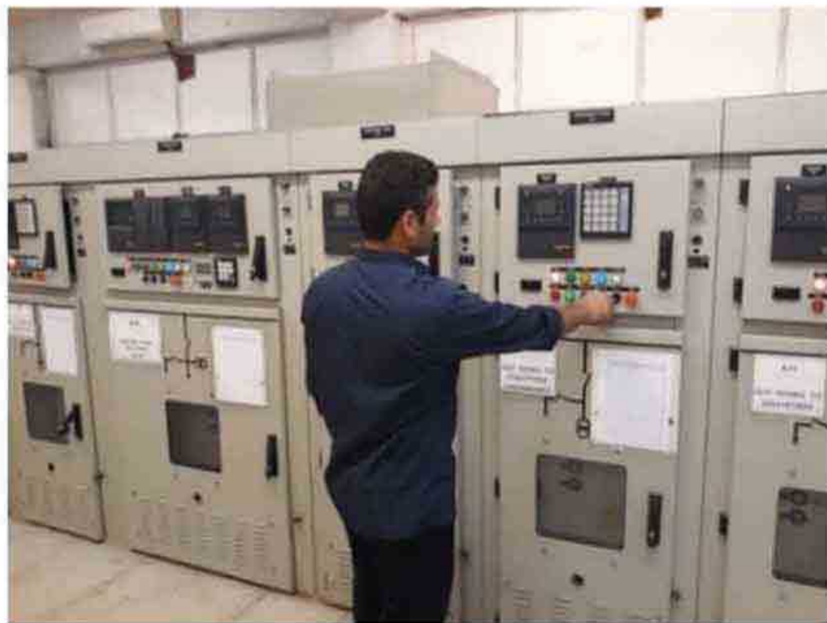
شکل ۹- کلیدزنی دستی از روی تابلو سویچ‌گیر
