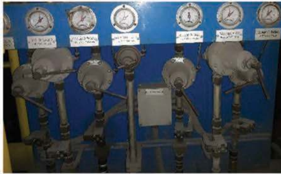
تصویر ۶: شیرکنترلی هوا و گاز طبیعی
